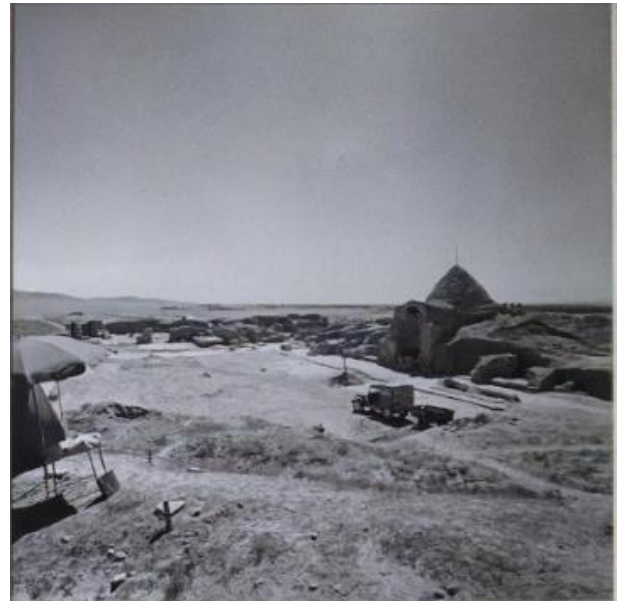
Vue générale des ruines du palais ghaznévide et ziarat d'Ibrahim
